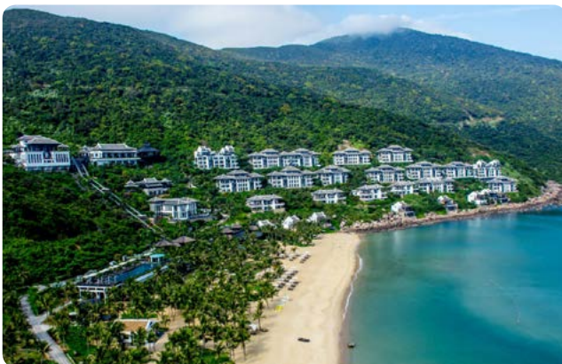
Hệ thống cáp ngầm tại các khu nghỉ dưỡng Underground cable system at resort
