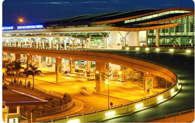
Hệ thống cáp ngầm tại các sân bay Underground cable system in airports
